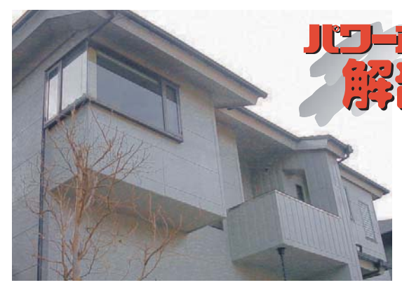
●築17年目のパワーボード使用住宅外観。全てのパネルにクラック、反り等の変化は見られませんでした。メンテナンスは3年前(築14年目)に外装塗装を実施。
